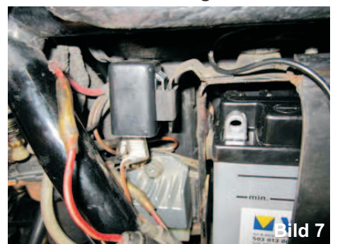
Blinkerrelais fertig montiert
